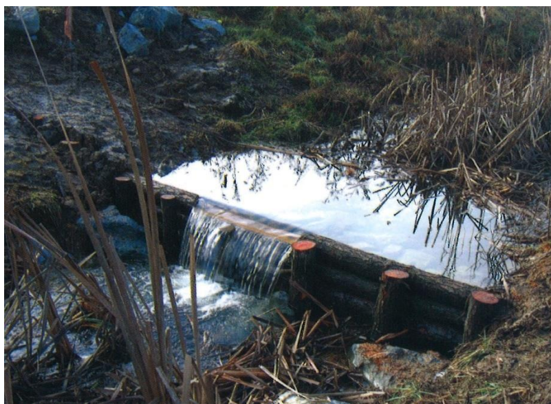
Slika 3.-8: Prag od drvenog materijala u koritu vodotoka
