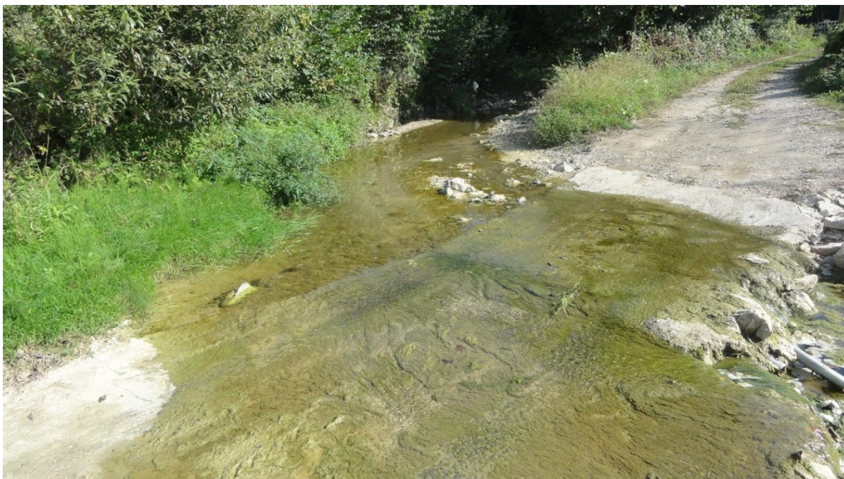
Slika 4.1.-8: VT 50128_1_T12 – Betonirani put kroz korito
