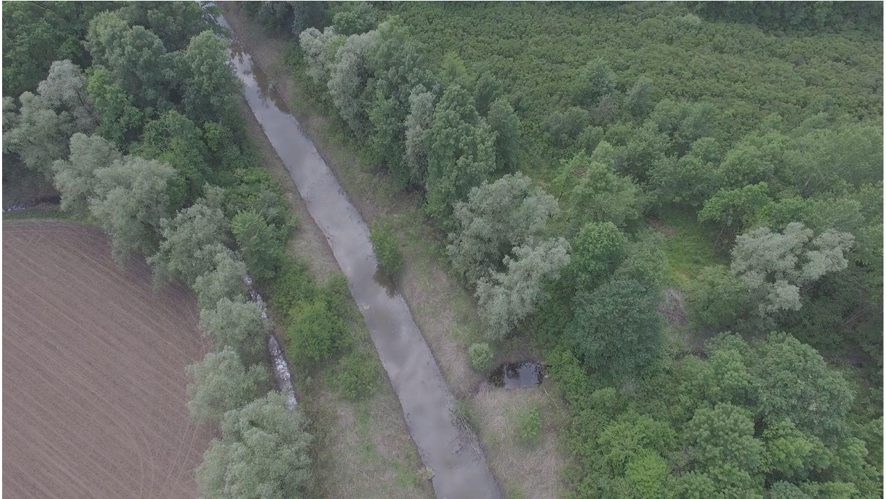
Slika 4.5.-4: VT 109061_2_A6 – Ispravljanje trase vodotoka
