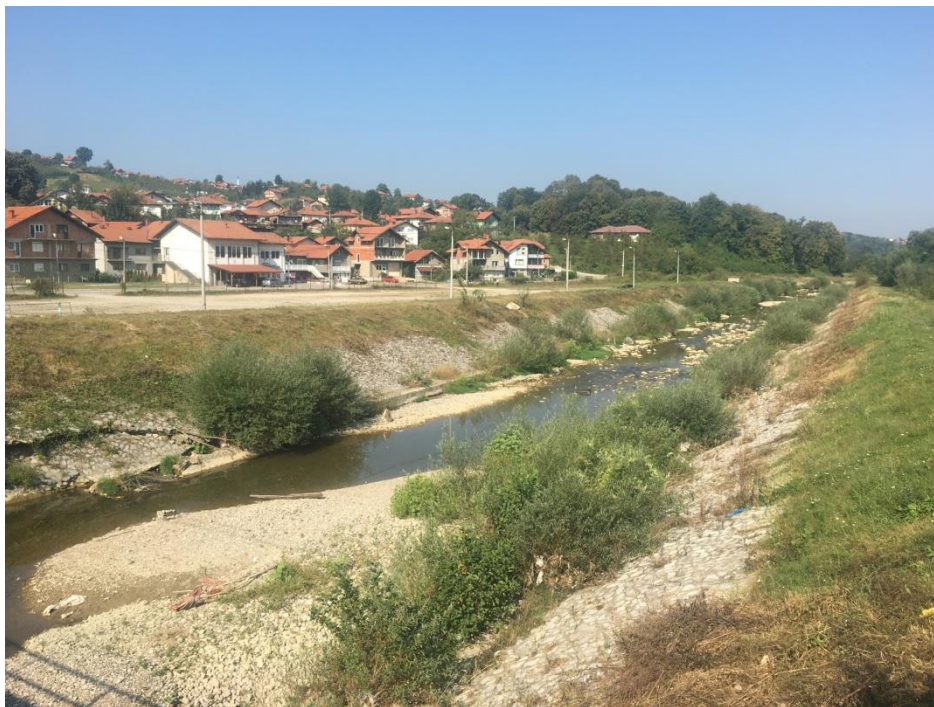
Slika 4.5.-3: VT 106029_1_T1– Oštećena obaloutvrda
