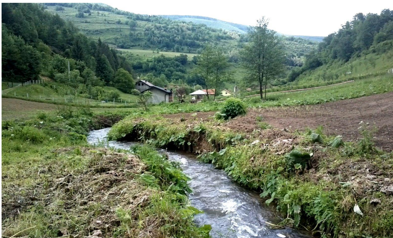
Slika 4.1.-4: VT 50046_2_B2 – Nestabilna obala s elementima erozije
