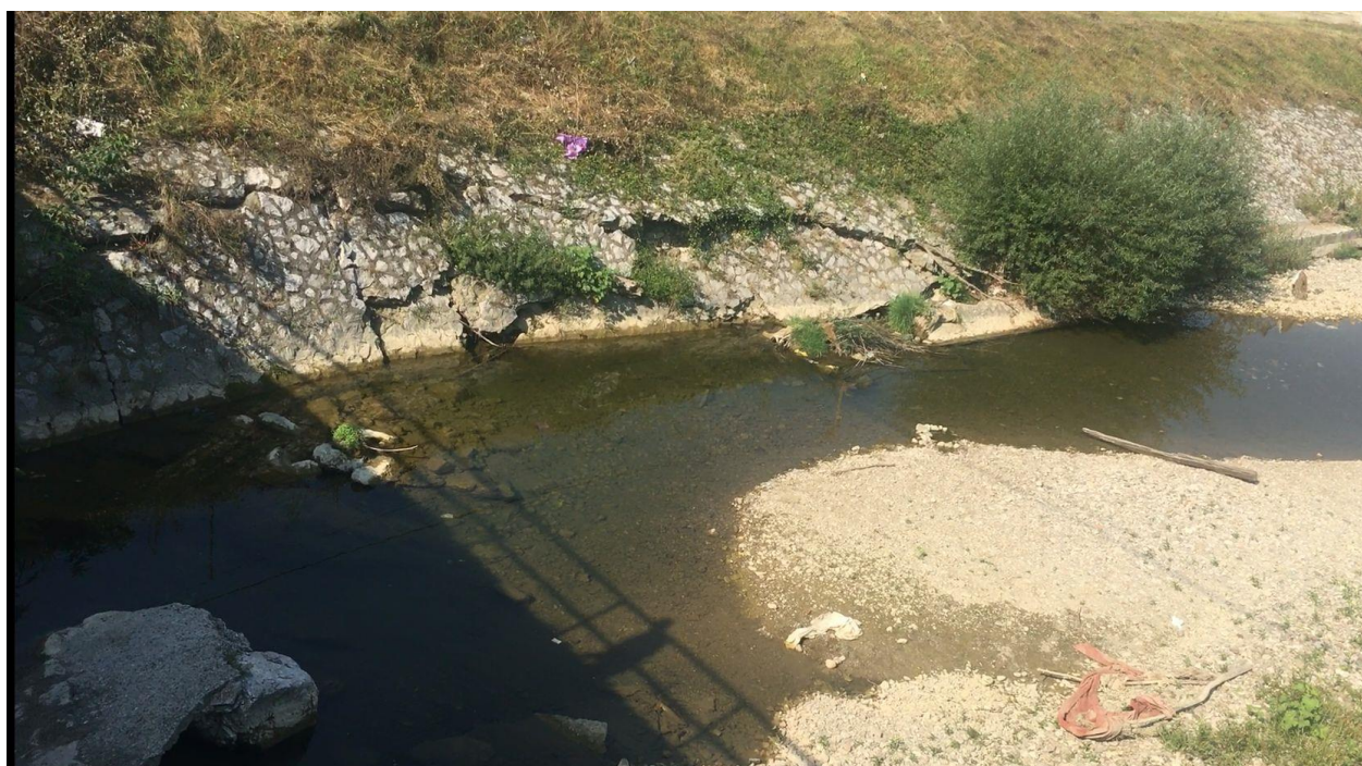
Slika 4.5.-2: VT 106029_1_T1 – Oštećena obaloutvrda
