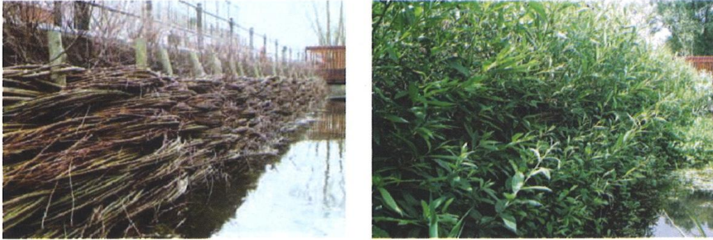
Slika 3.-21: Pogled na dionicu pokosa stabiliziranog fašinama neposredno nakon izvedbe i nakon godinu dana
