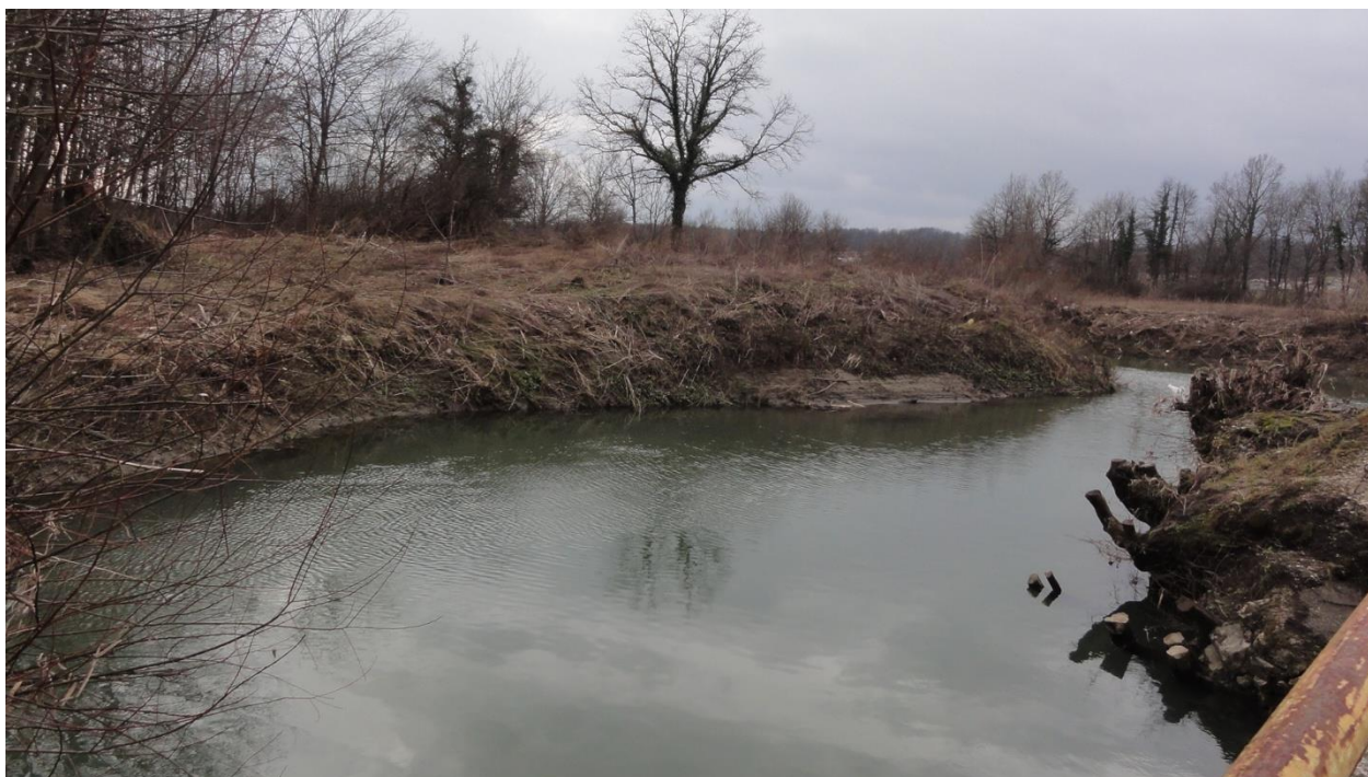
Slika 4.2.-1: VT 213089_1_B3 – Prokopavanje, produbljivanje i ispravljanje trase korita
