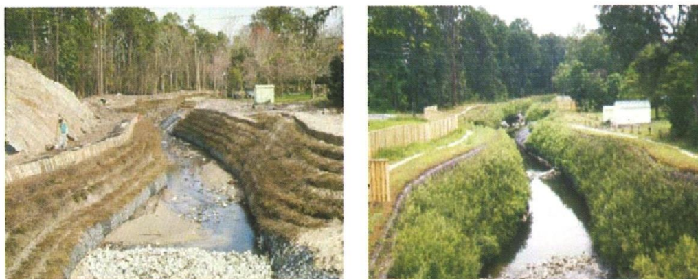
Slika 3.-20: Pogled na dionicu pokosa stabiliziranog geotekstilom za vrijeme izvedbe i nakon godinu dana
