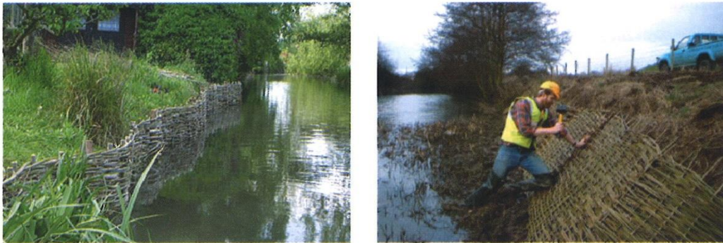
Slika 3.-22: Drveni plot i izvedba fašinskog tepiha
