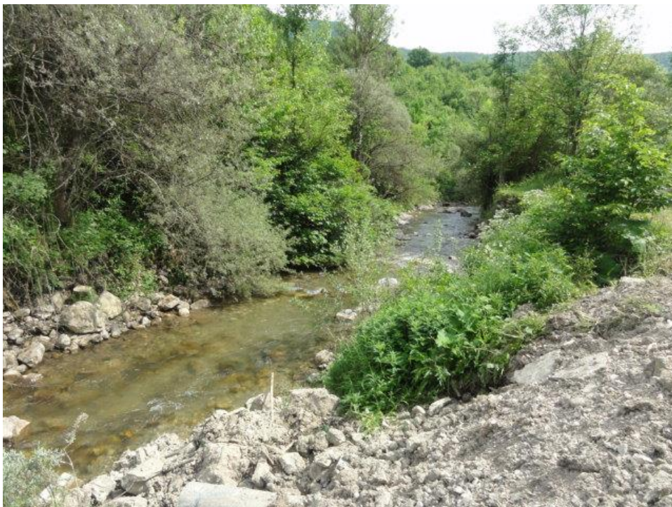
Slika 3.-2: Vodno tijelo Bukovice – primjer zabranjenog načina odlaganja viška materijala iz iskopa i građevinskog otpada na obali
