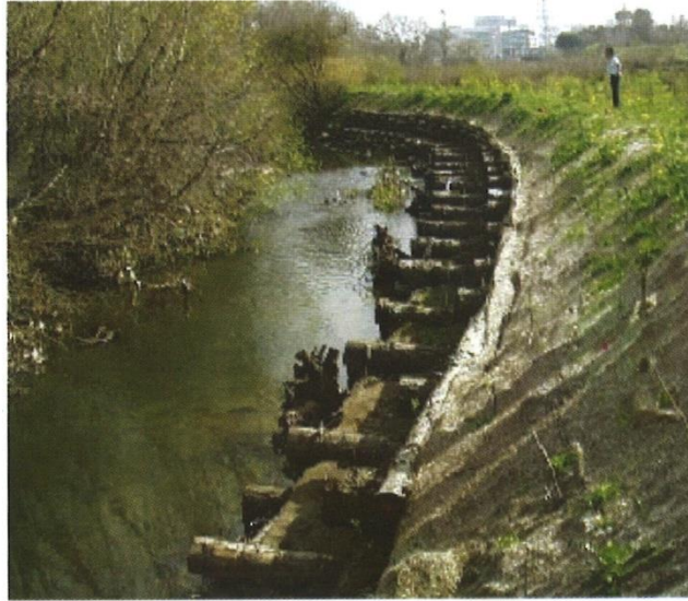
Slika 3.-23: Pogled na dionicu pokosa stabiliziranog drvenim talpama
