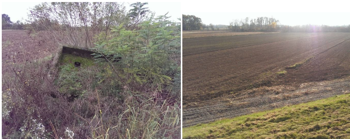
Uklanjanje bunkera (prije i poslije)
