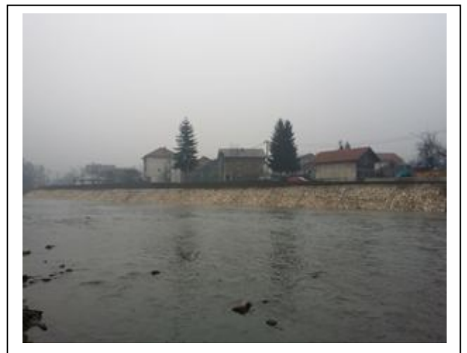
Slika nakon izvođenja radova
