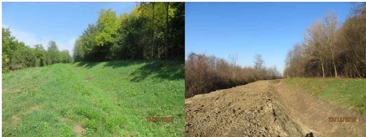
Čišćenje kanala (prije i poslije)
