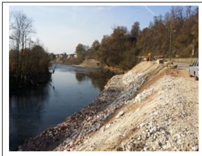
Slika nakon izvođenja radova
