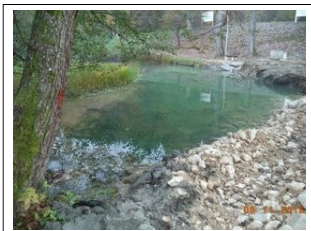
Slika nakon izvedenih radova
