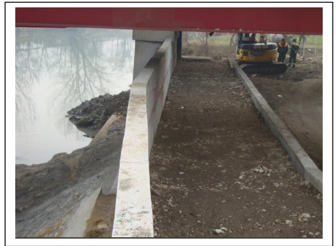
Nakon završetka radova
