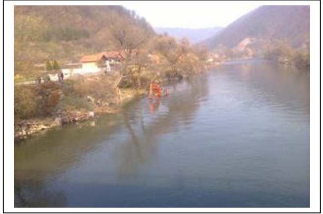
Slika nakon izvedenih radova
