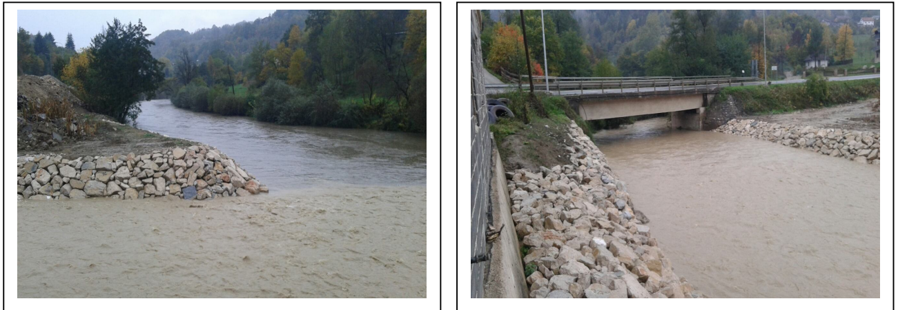
Slika nakon izvedenih radova
