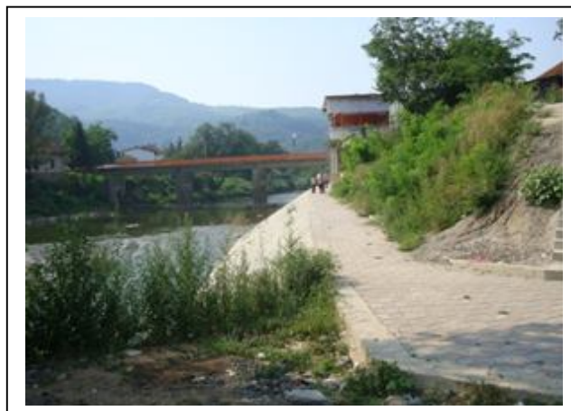
Slike nakon završetka radova
