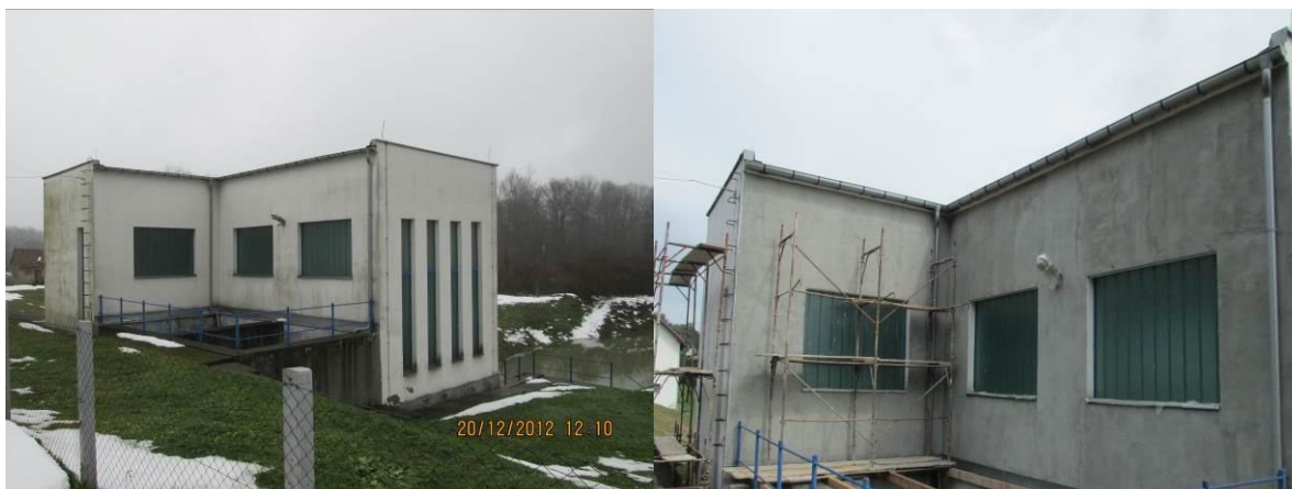
Sanacija objekta CS Svilaj (prije i poslije)
