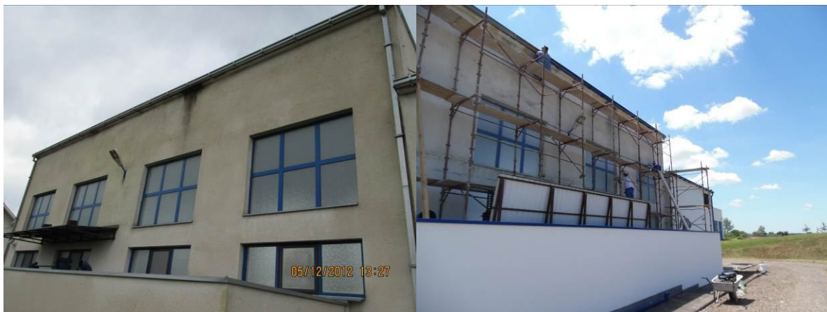
Sanacija objekta CS Zorice I (prije i poslije)
