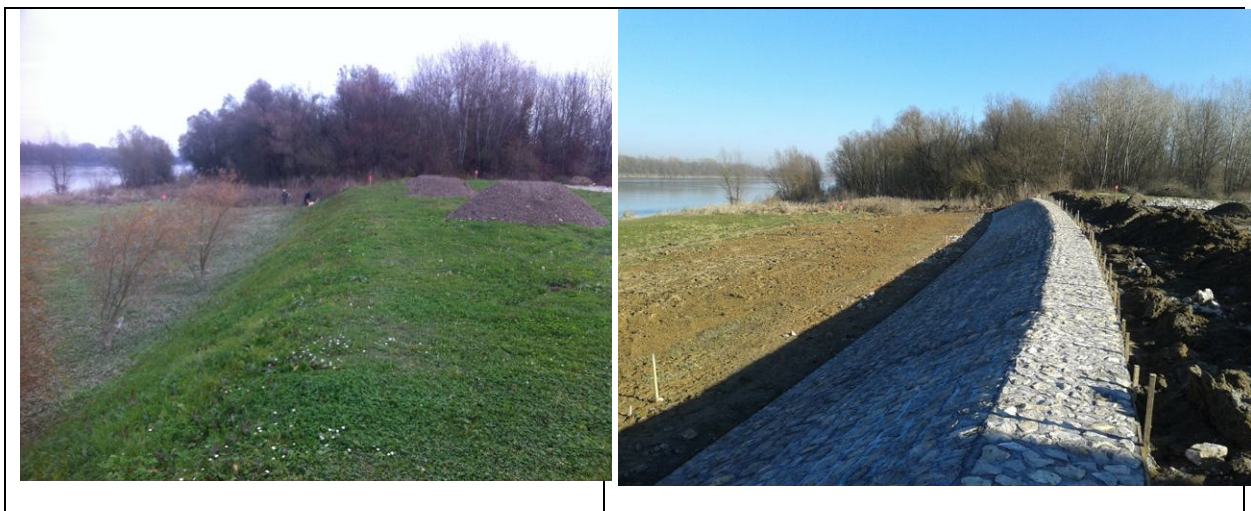
Desna obala rijeke Save prije i nakon izvedenih radova
