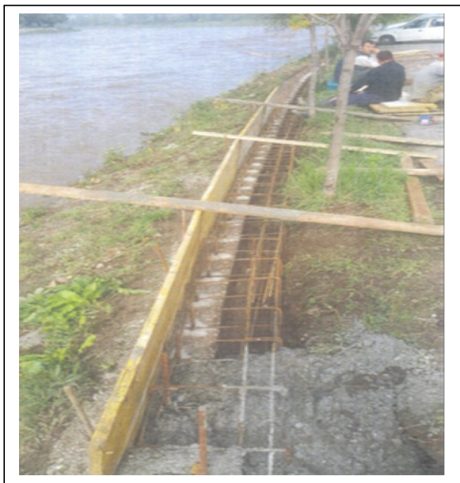
Slika u toku izvođenja radova
