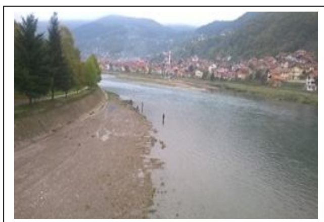
Slika nakon izvođenja radova
