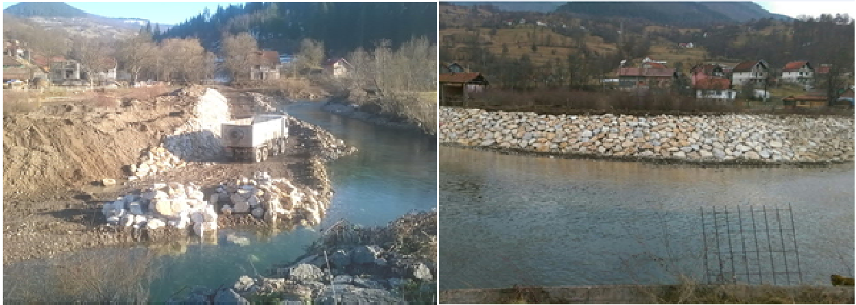
Obala rijeke Krivaje u naselju Solun prije i nakon izvedenih radova
