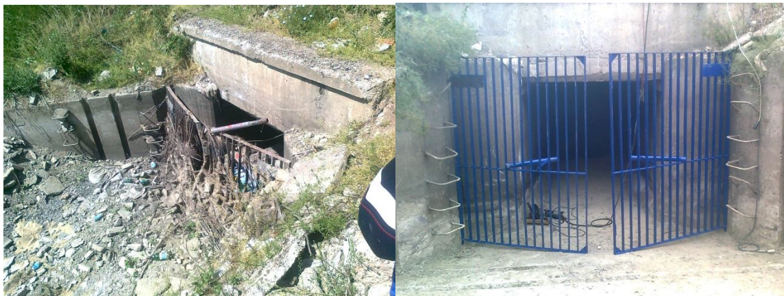
Izrada grube rešetke (prije i poslije)
