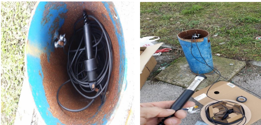
Sonde za mjerenje nivoa podzemne vode i kablovi za prenos podataka
