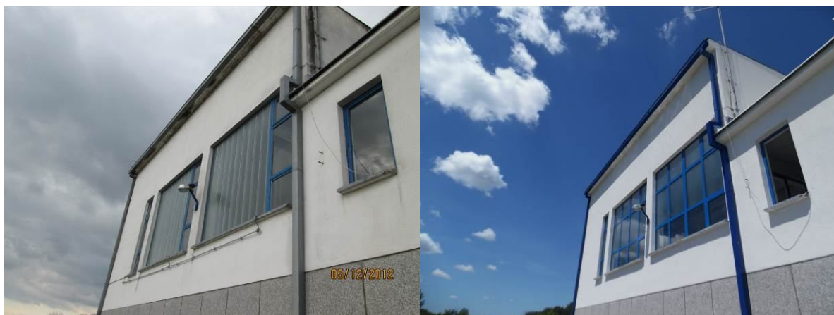
Sanacija objekta CS Zorice II (prije i poslije)
