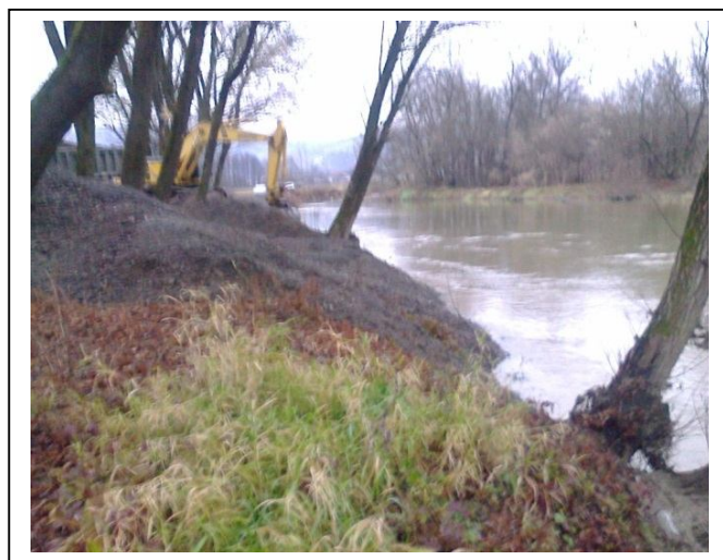
U toku izvođenja radova
