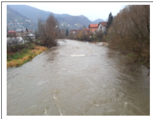
Slika prije izvođenja radova
