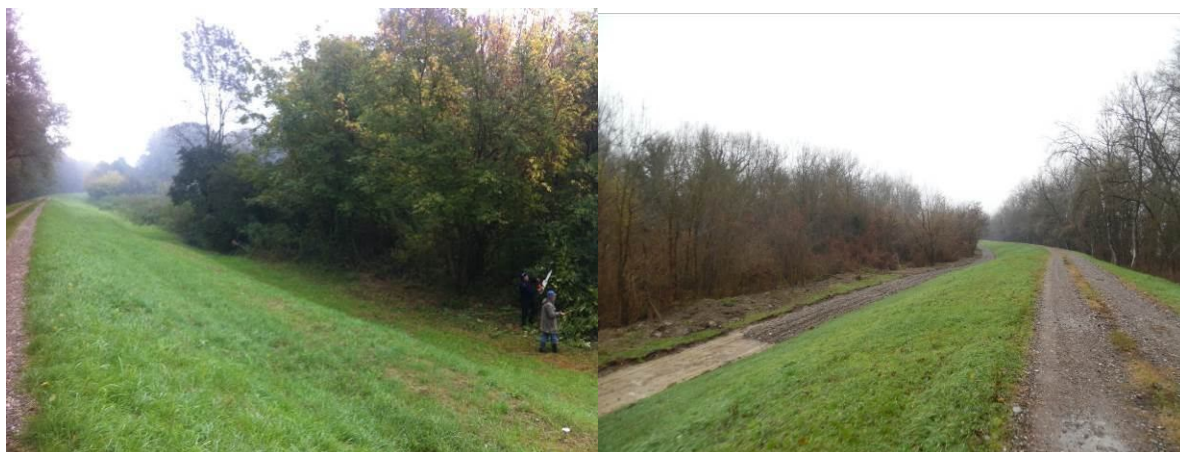
Sanacija pristupnog puta Svilaj - Kadar
