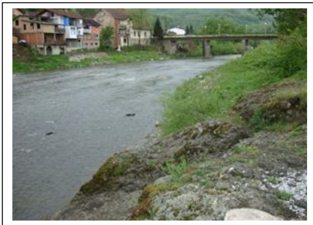
Slike prije izvođenja radova
