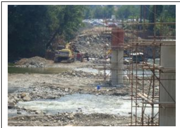
Slika u toku izvođenja radova
