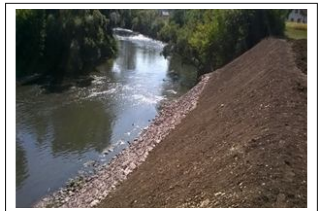
Slika nakon izvođenja radova
