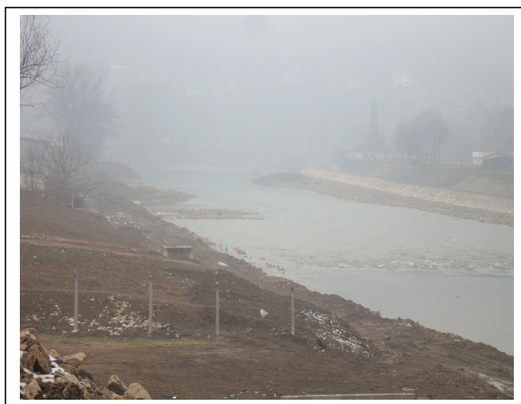
Slika u toku izvođenja radova
