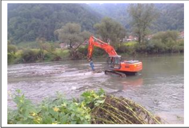
Slika u toku izvođenja radova
