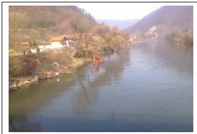
Slika prije izvođenja radova
