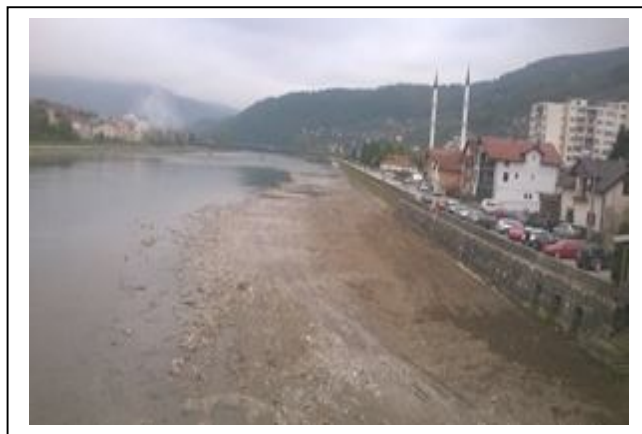
Slika nakon izvođenja radova
