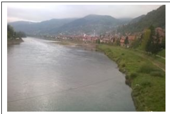
Slika prije izvođenja radova
