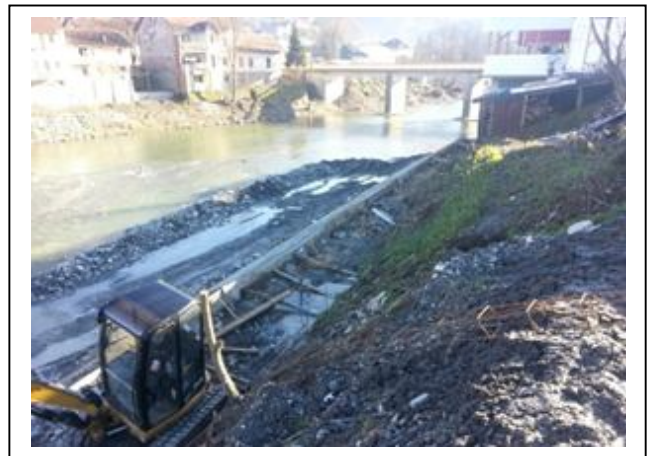
Slika u toku izvođenja radova
