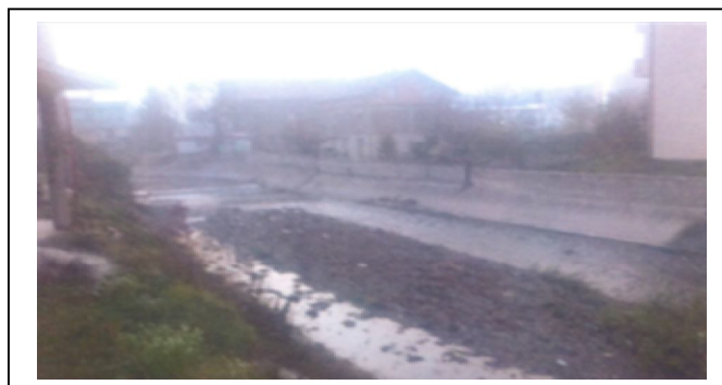
Slika prije čišćenja predmetne lokacije
