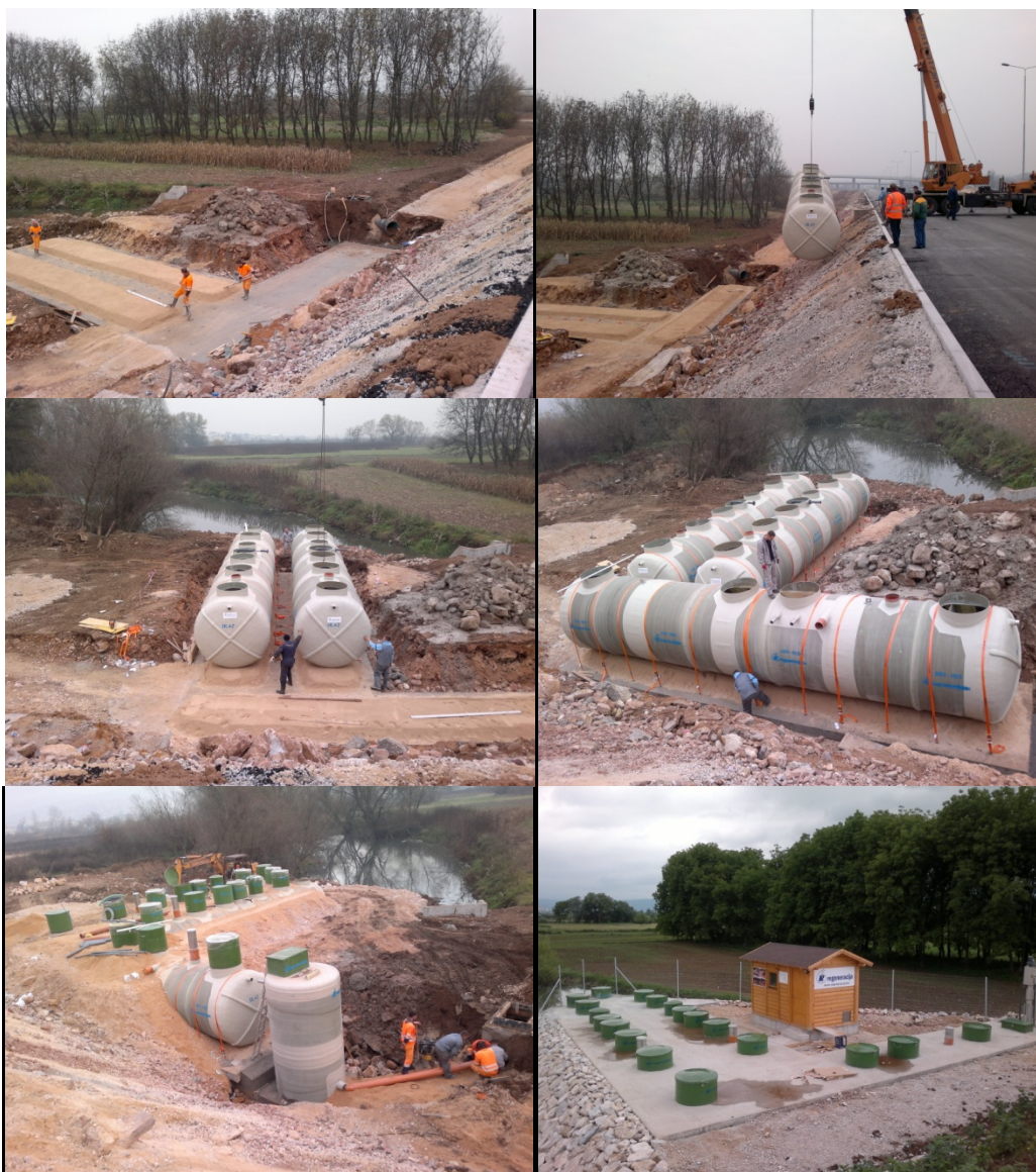
Slika 5. Faze ugradnje SBR_REG_1000 uređaja
