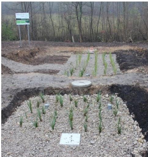
Slika 2 i 3. Pilot biljni uređaj izgrađen na Biotehničkom fakultetu Univerziteta u Bihaću
