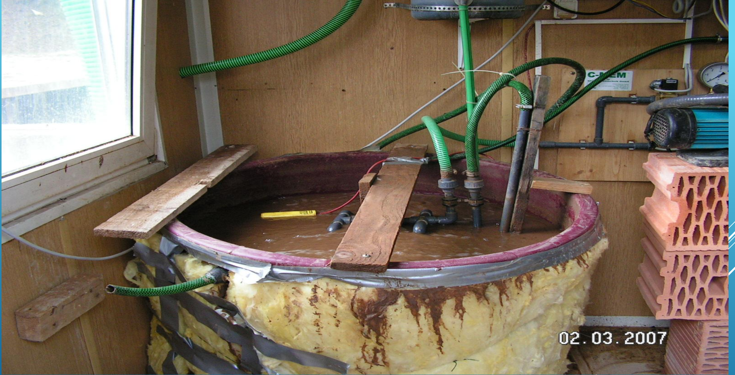
DETALJI PILOT POSTROJENJA
