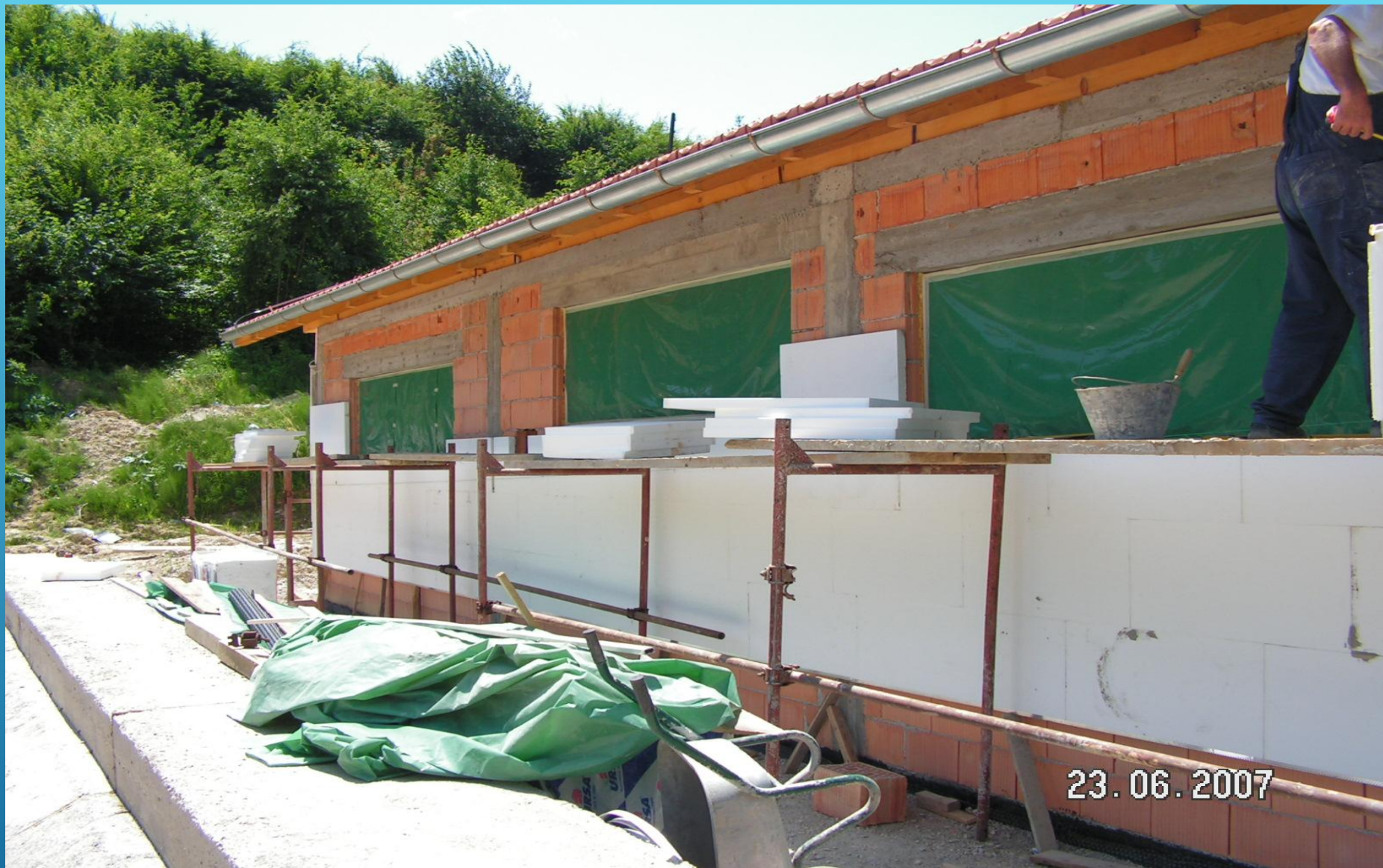
DETALJI IZRADE KOMANDNE ZGRADE NA PRČISTAČU (2)
