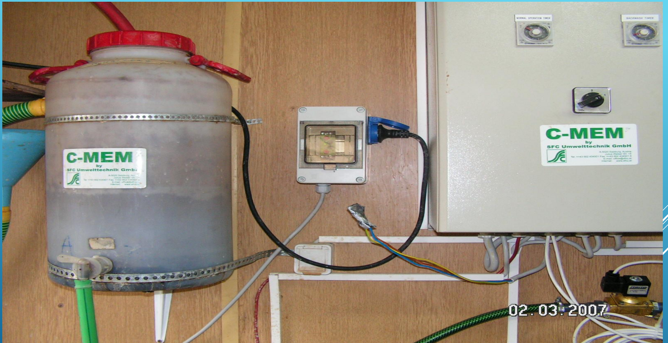
DETALJI PILOT POSTROJENJA (3)
