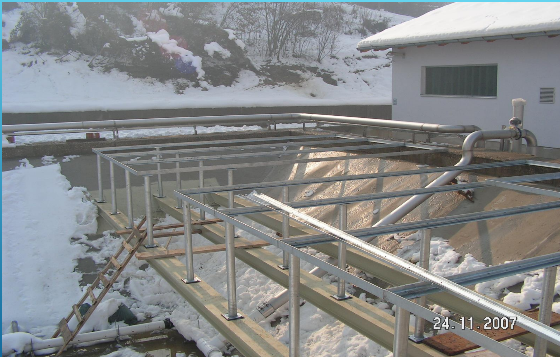
POČETAK MONTAŽE GALERIJE (1)
