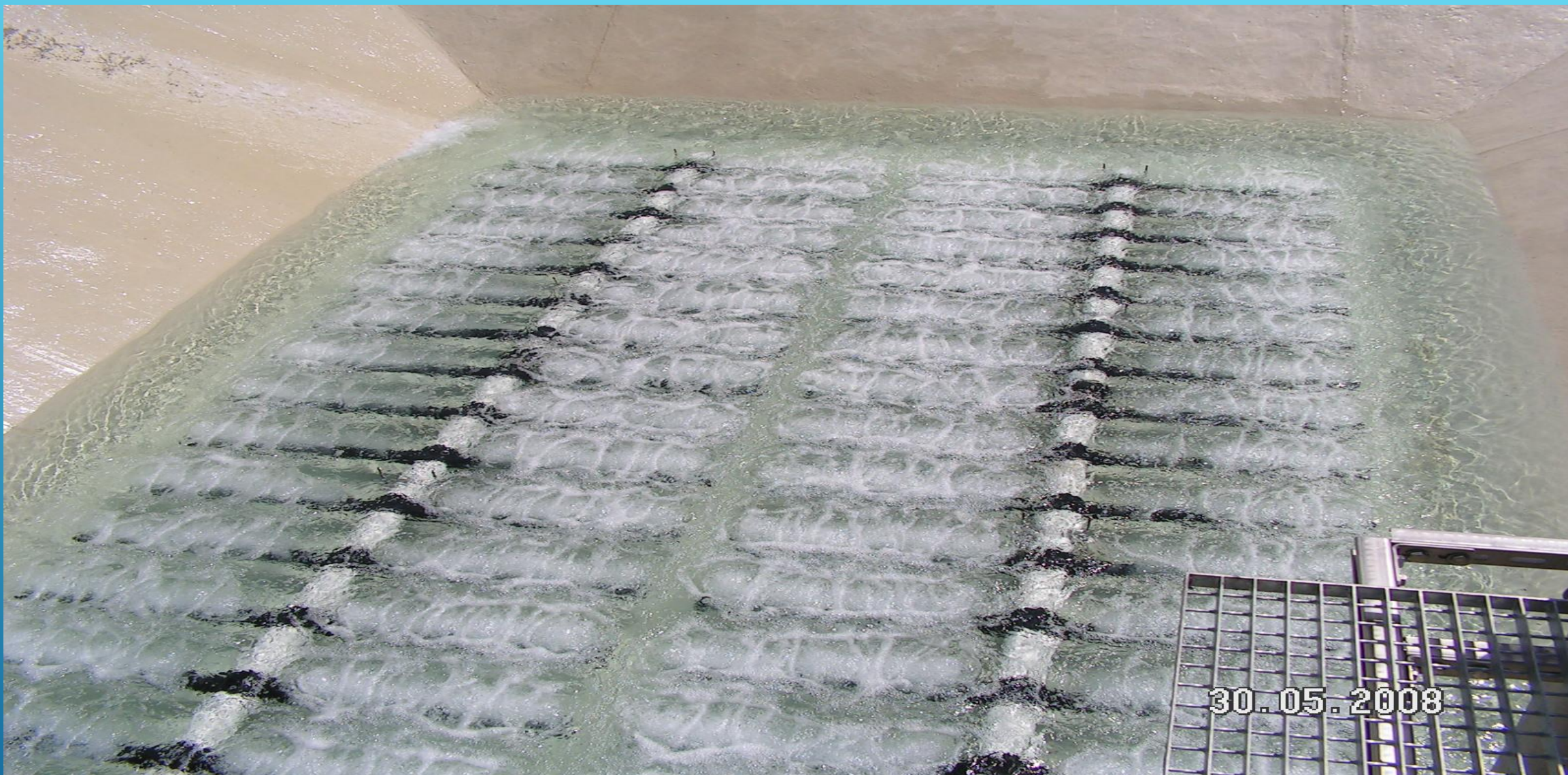
AERACIJA U DRUGOM BAZENU SA DETALJOM JEDNOG OŠTEČENJA (7)
