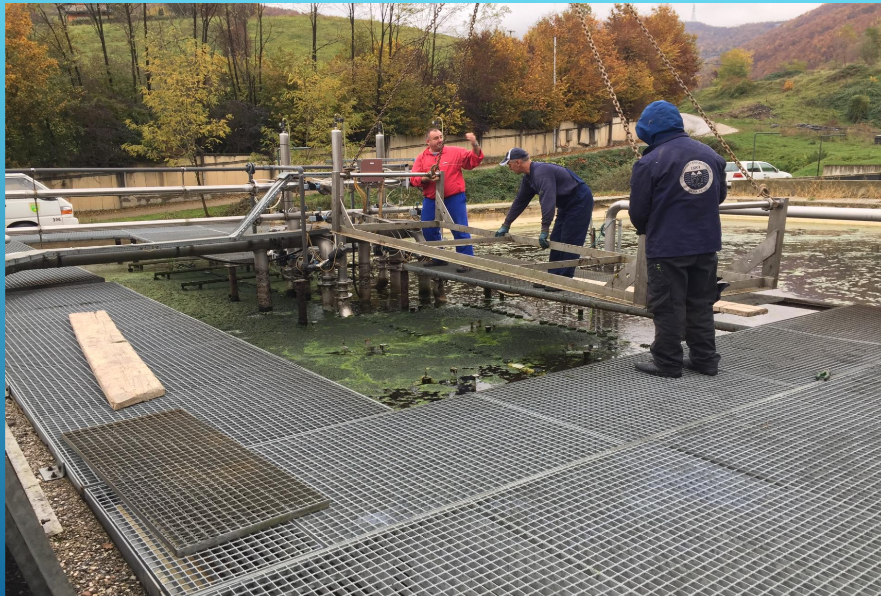
POSTAVLJANJE PODKONSTRUKCIJE ZA VAĐENJE MODULA (2)
