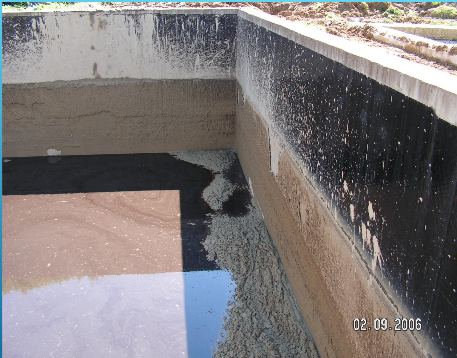
NASLAGE TALOGA NA STIJENKAMA BAZENA ZA PROCJEDNE VODE
