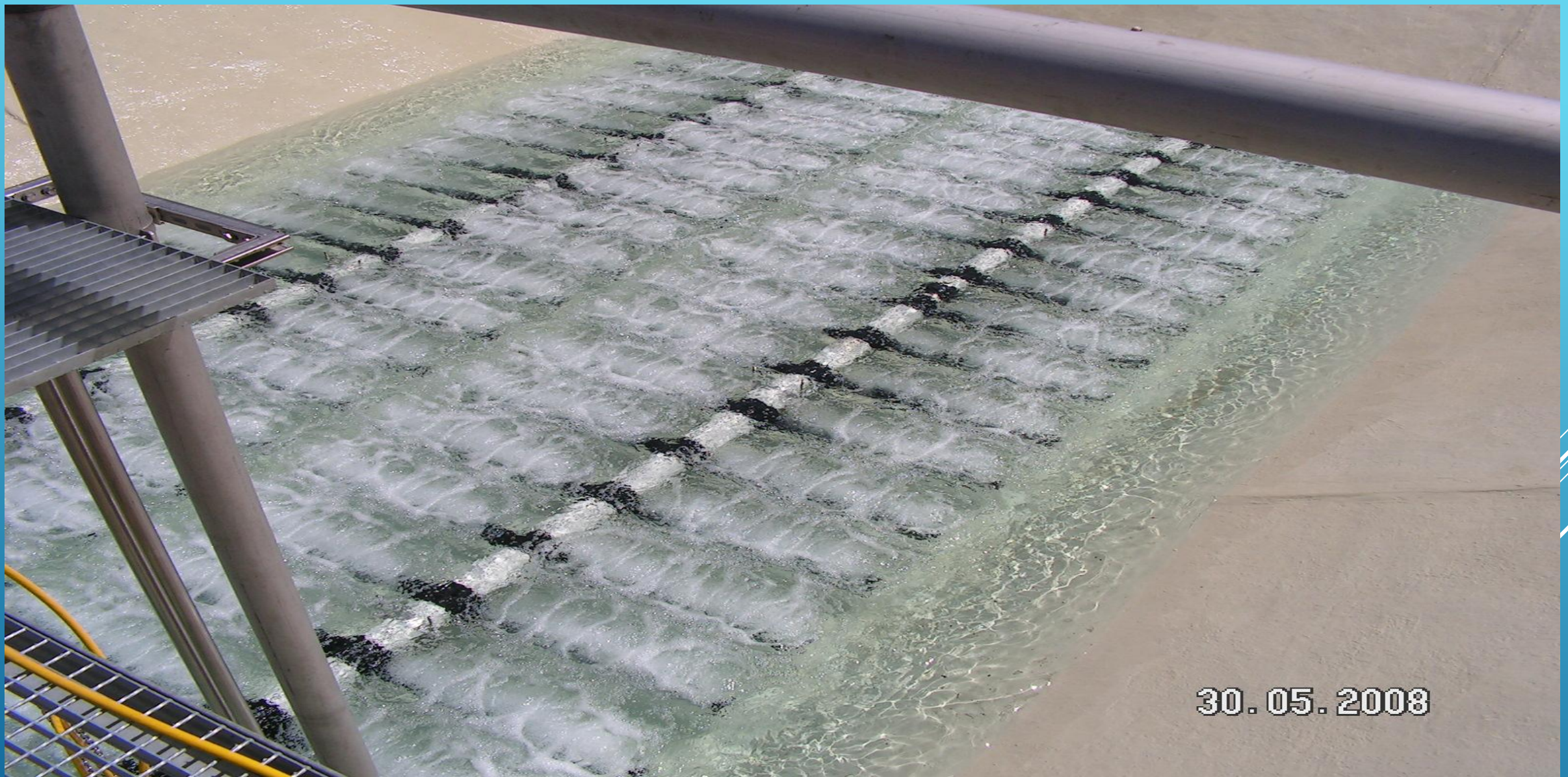
AERACIJA U DRUGOM BAZENU SA DETALJOM JEDNOG OŠTEČENJA (5)
