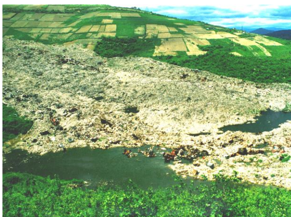
Slika 1 Procjedne vode u tijelu odlagališta prije ugradnje sistema za prikupljanje
