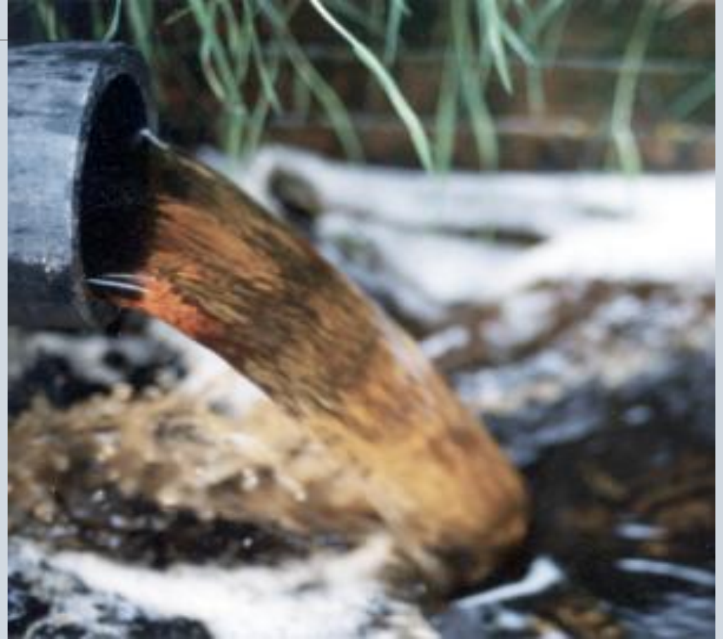
Procjedne vode prikupljene drenažnim sistemom
