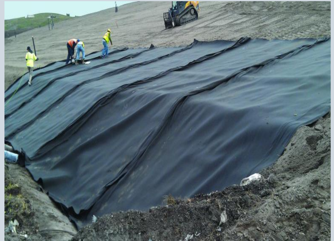
Polaganje HDPE folije u gornji zaptivni sloj na deponiji
