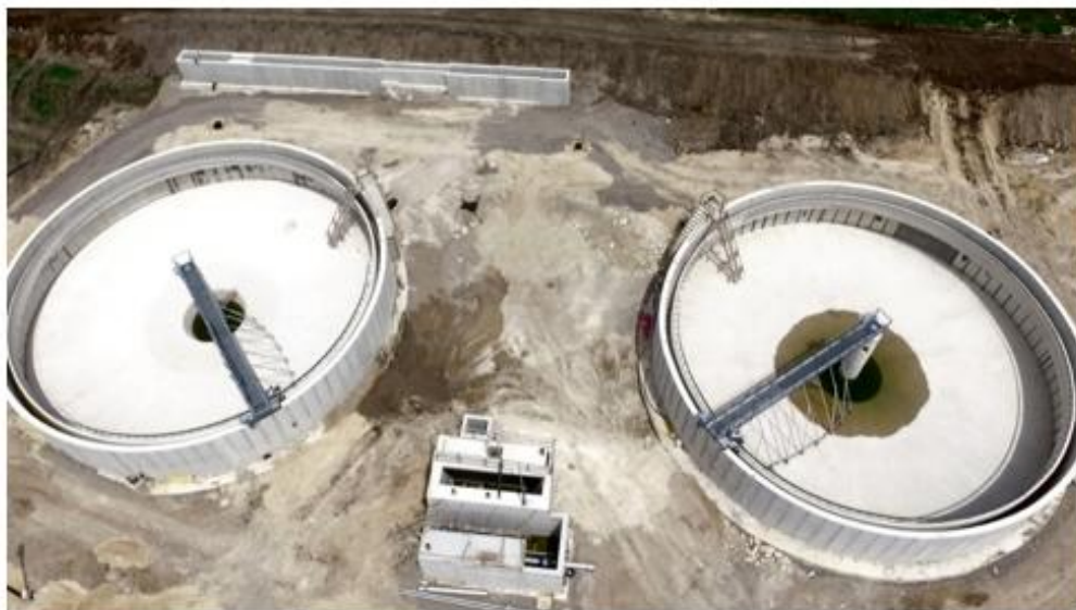
Slika 4-14: Finalni taložnici
