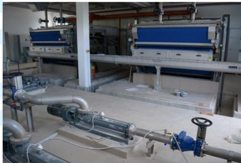
Slika 4-18: Trakaste prese za dehidraciju mulja
