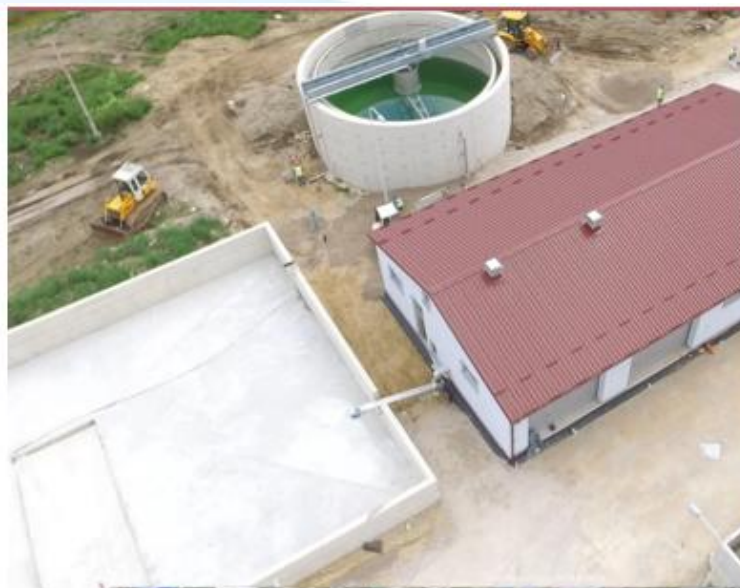
Slika 4-19: Spremište mulja, zgrada sa opremom za dehidraciju mulja i gravitacijski ugušćivač mulja
