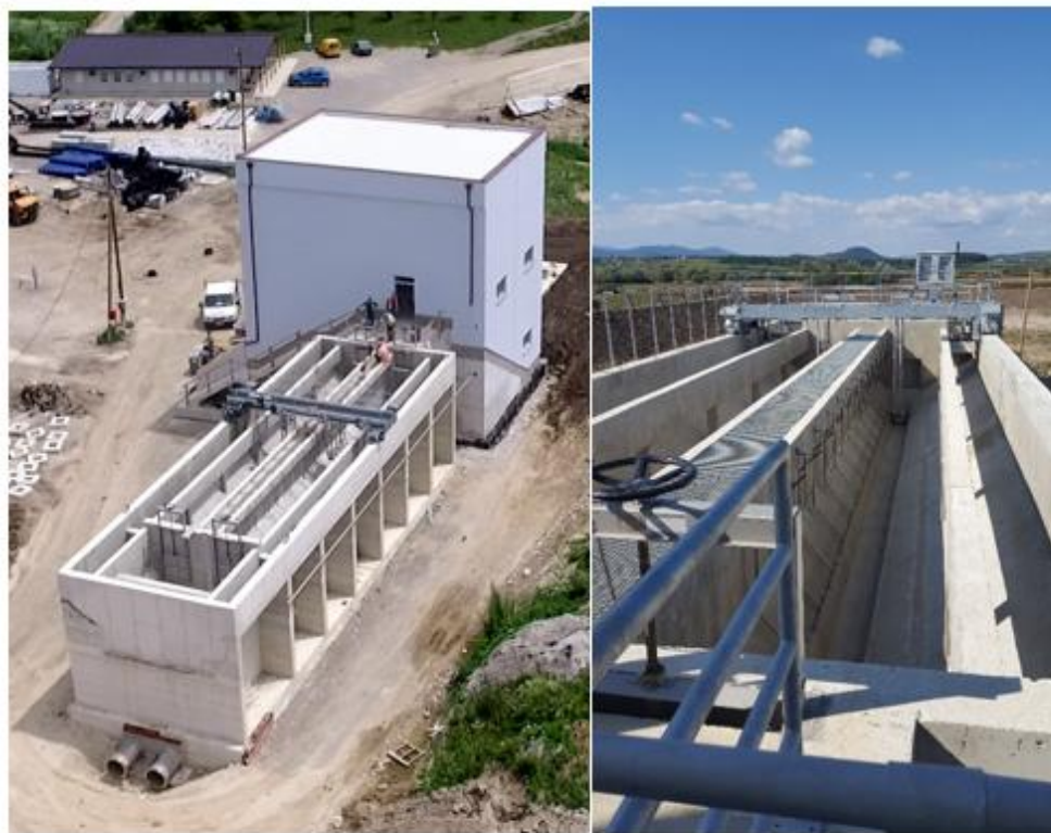
Slika 4-8: Objekat pjeskolova i mastolova sa pokrenim zgrtačem
