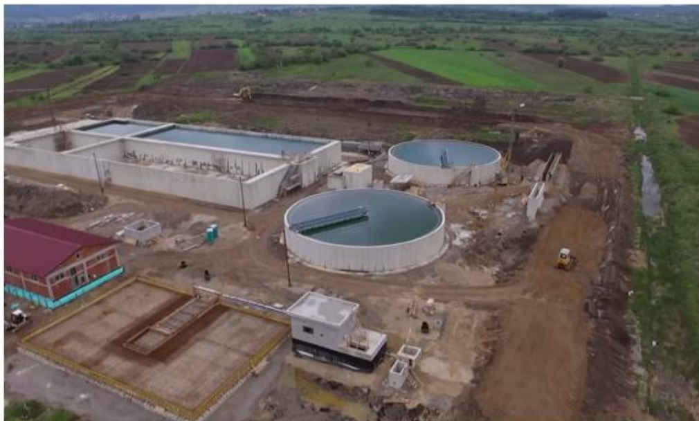
Slika 4-20: Odbambeni nasip u fazi izgradnje, april 2016.god.
