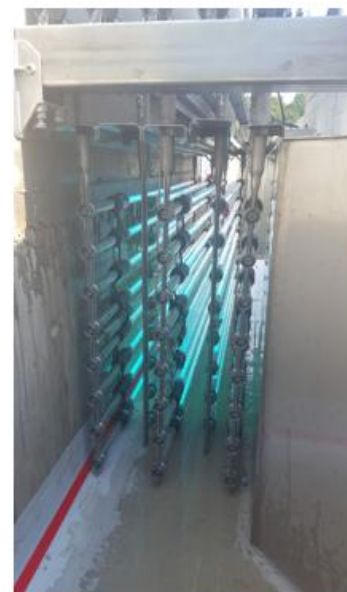
Slika 4-16: UV sistem – suha proba PPOV Bihać
