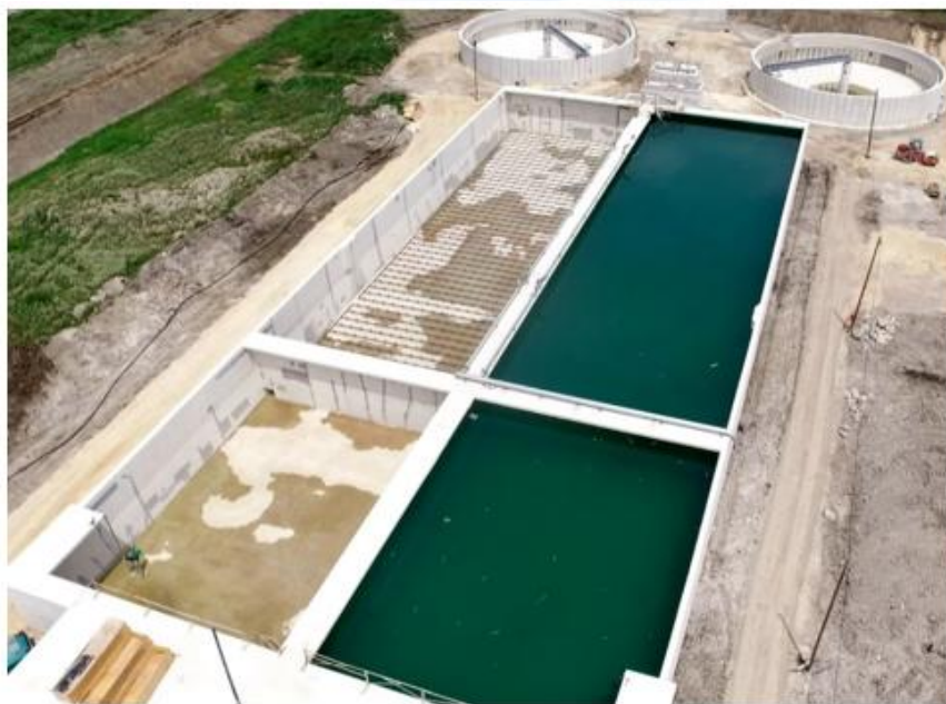
Slika 4-9: Bioeracijski bazeni – „srce postrojenja za prečišćavanje otpadnih voda“
