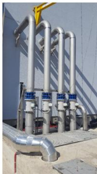
Slika 4-4: Potisni cjevovodi iznad ulazne pumpne stanice
