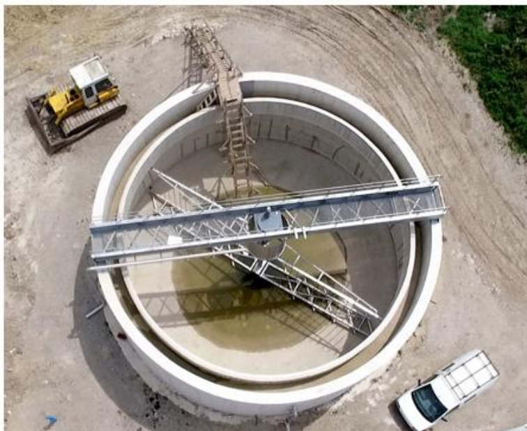
Slika 4-17: Gravitacijski ugušćivač mulja
