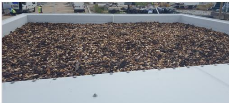
Slika 4-7: Filtarski sloj biomase na uređaju za uklanjanje neugodnih mirisa
