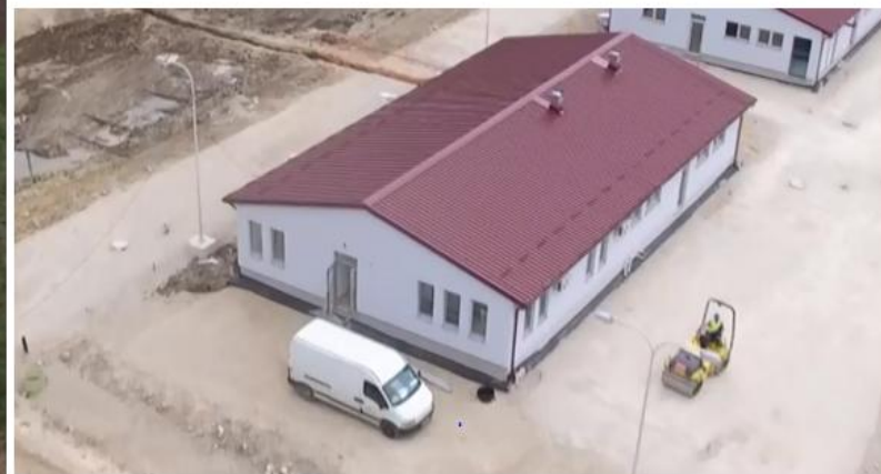
Slika 4-22: Administrativna zgrada u fazi izvođenja završnih radova i pripreme za asfaltiranje unutrašnjih saobraćajnica
