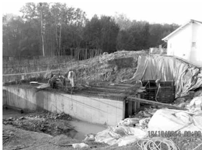
Sl.5. Izvođenje radova
