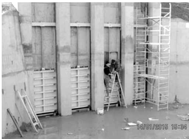
Sl.6. Izvođenje radova
