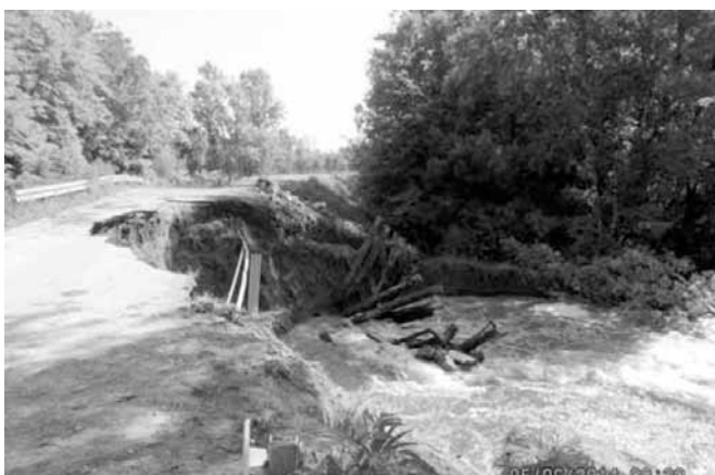
Sl.2. Izgled odbranbenog savskog nasipa sa vodne strane u toku trajanja velike vode, na mjestu srušene gravitacione ustave
