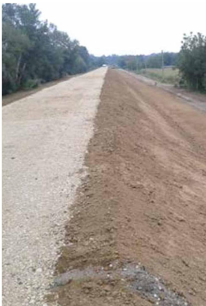
Sl.11. Izvođenje radova
