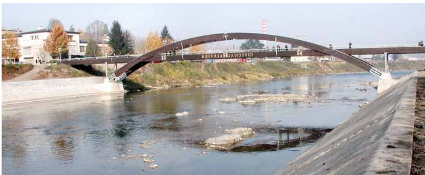
Slika 3– Zavidovići, most DUGA
