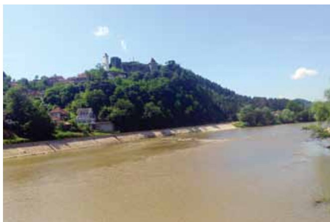
Slika 8 – Maglaj, desna obala rijeke Bosne, uzvodno od mosta nakon radova
