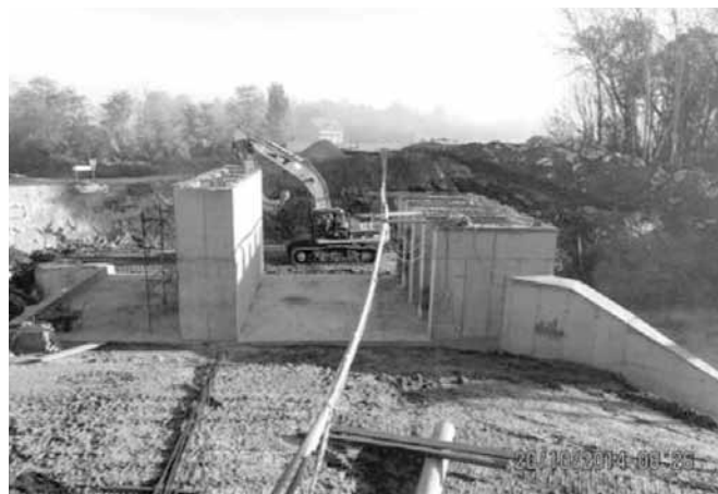
Sl.4. Izvođenje radova
