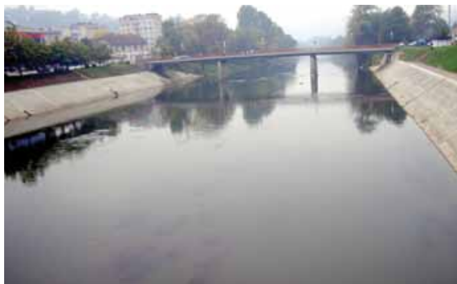
Slika 1– Zavidovići, uređenje obala rijeke Bosne nakon radova
