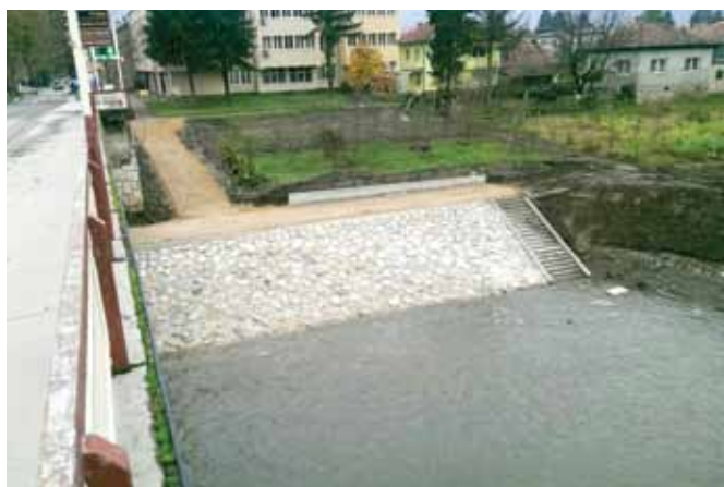
Slika 5 – Maglaj, lijeva obala rijeke Bosne nizvodno od mosta
