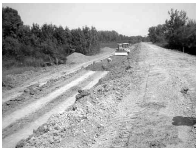
Sl.8. Izvođenje radova
