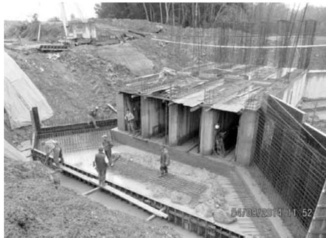
Sl.3. Izvođenje radova
