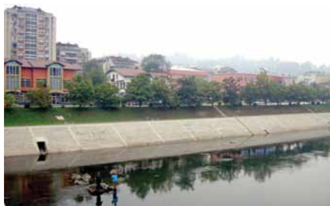
Slika 2– Zavidovići, desna obala rijeke Bosne nakon radova
