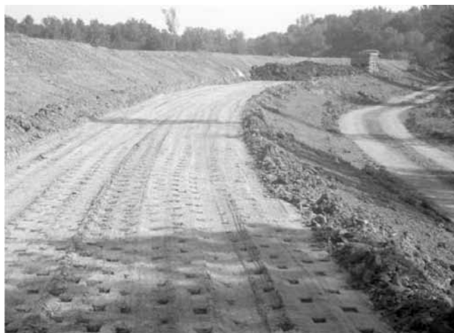
Sl.9. Izvođenje radova
