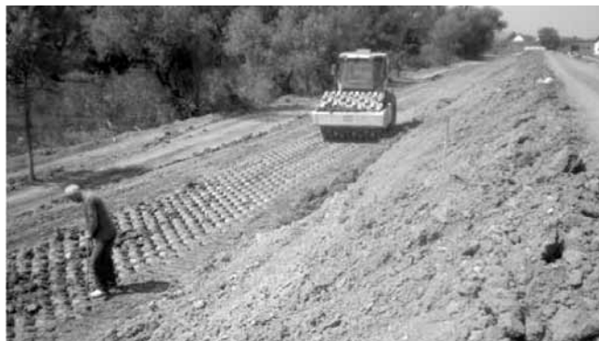
Sl.7. Izvođenje radova
