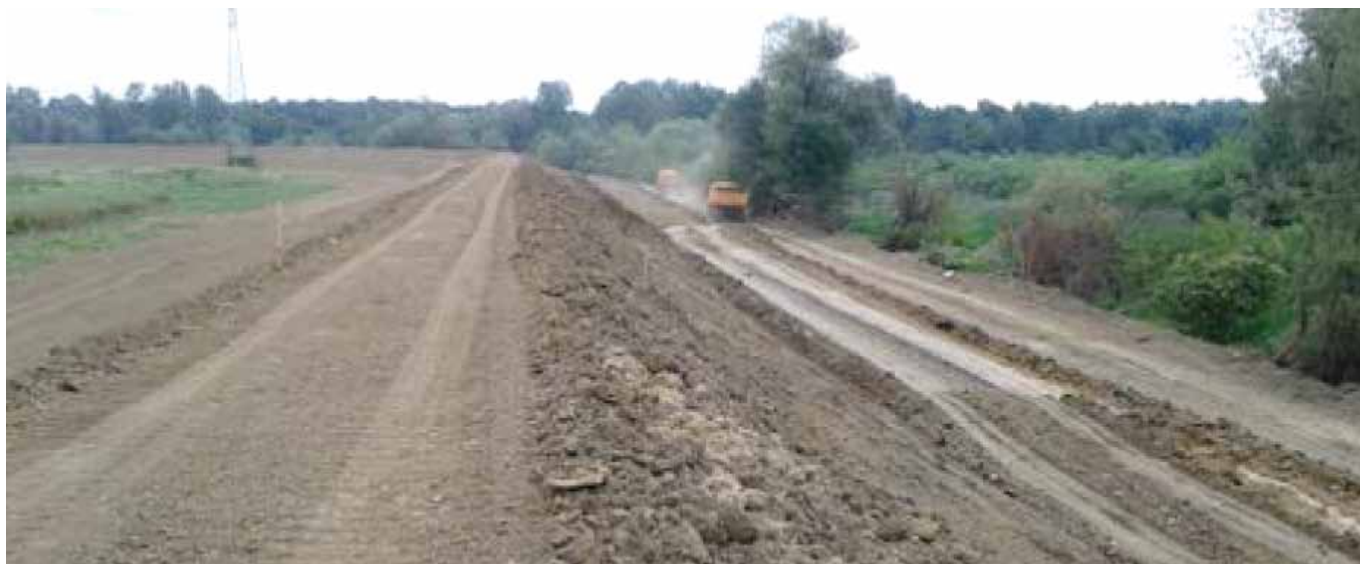
Sl.10. Izvođenje radova
