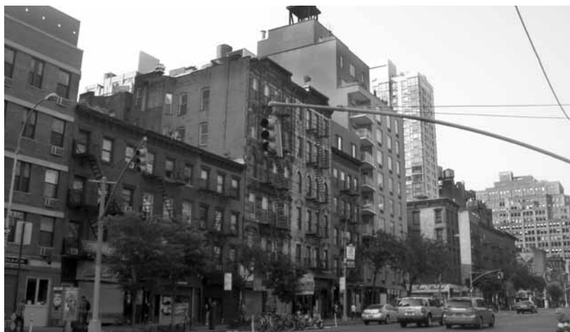
Slika 6. Vodotornjevi na prosječno visokim zgradama New Yorka su uobičajena pojava. Iako izgledaju zastarjelo, još uvijek su u funkciji
