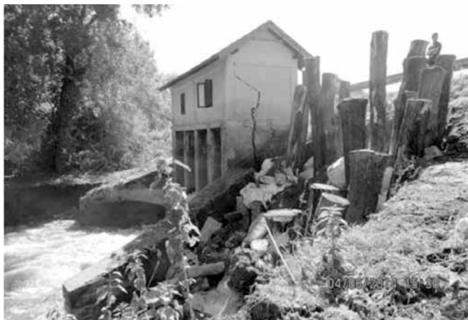
Sl.1. Izgled stare gravitacione ustave
