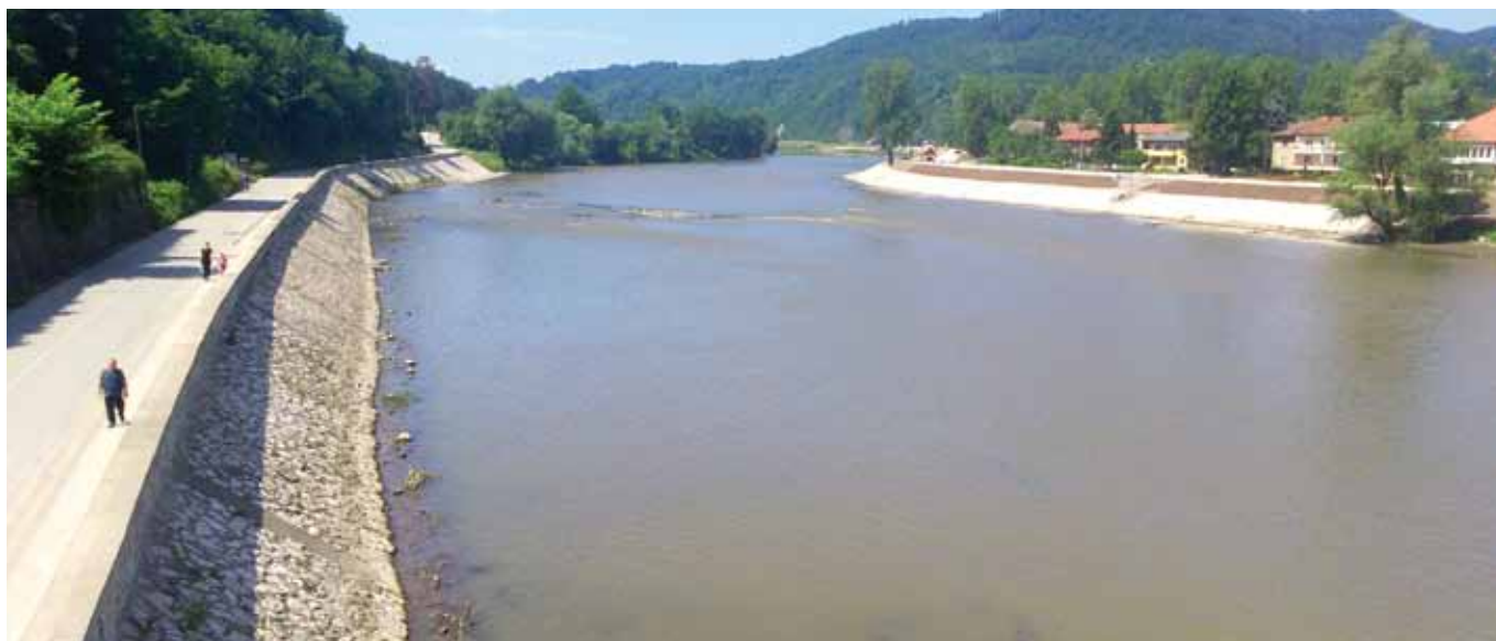
Slika 7 – Maglaj, uzvodno od mosta nakon radova
