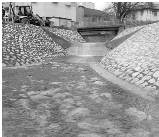
Slika 4 – Žepče ušće r. Krajnjače, nakon radova
