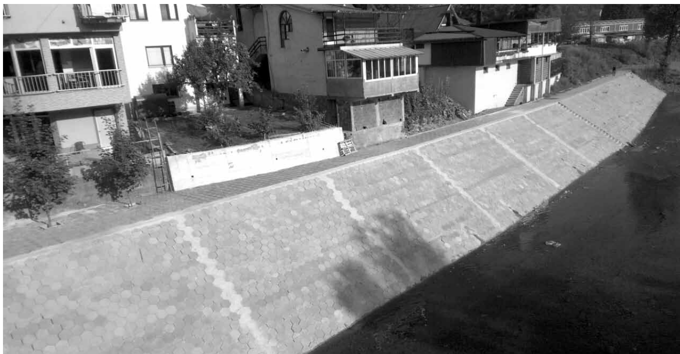
Slika 8– Zavidovići, lijeva obala Krivaje pogled s mosta, nakon radova
