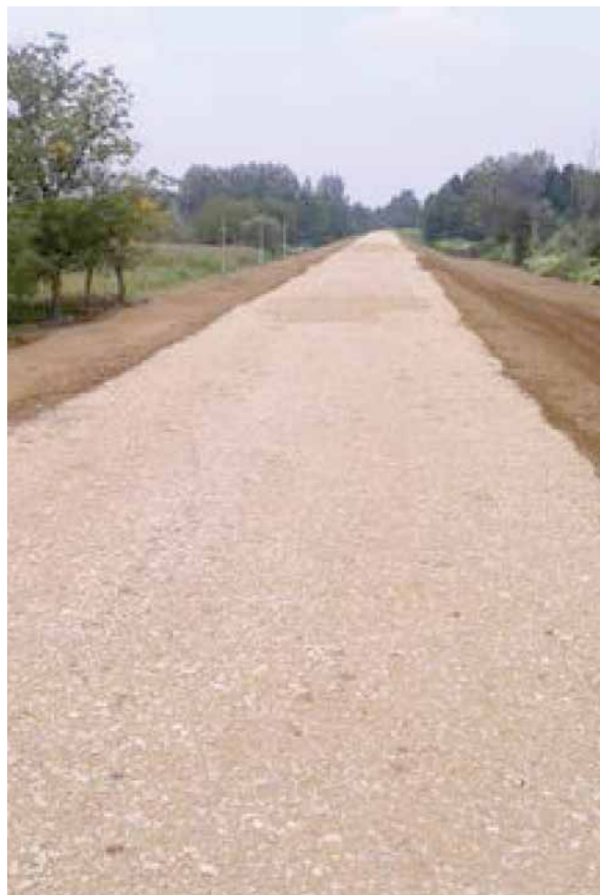
Sl.12. Izvođenje radova
