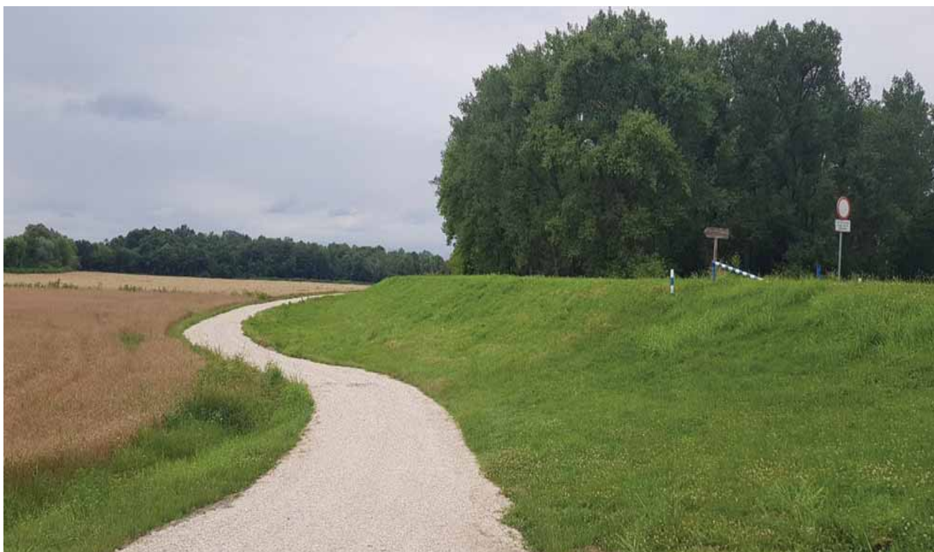
Pristupni put uz savski nasip – osigurava vizuelni pregled i interventni pristup duž cijele trase odbrambenog sistema
