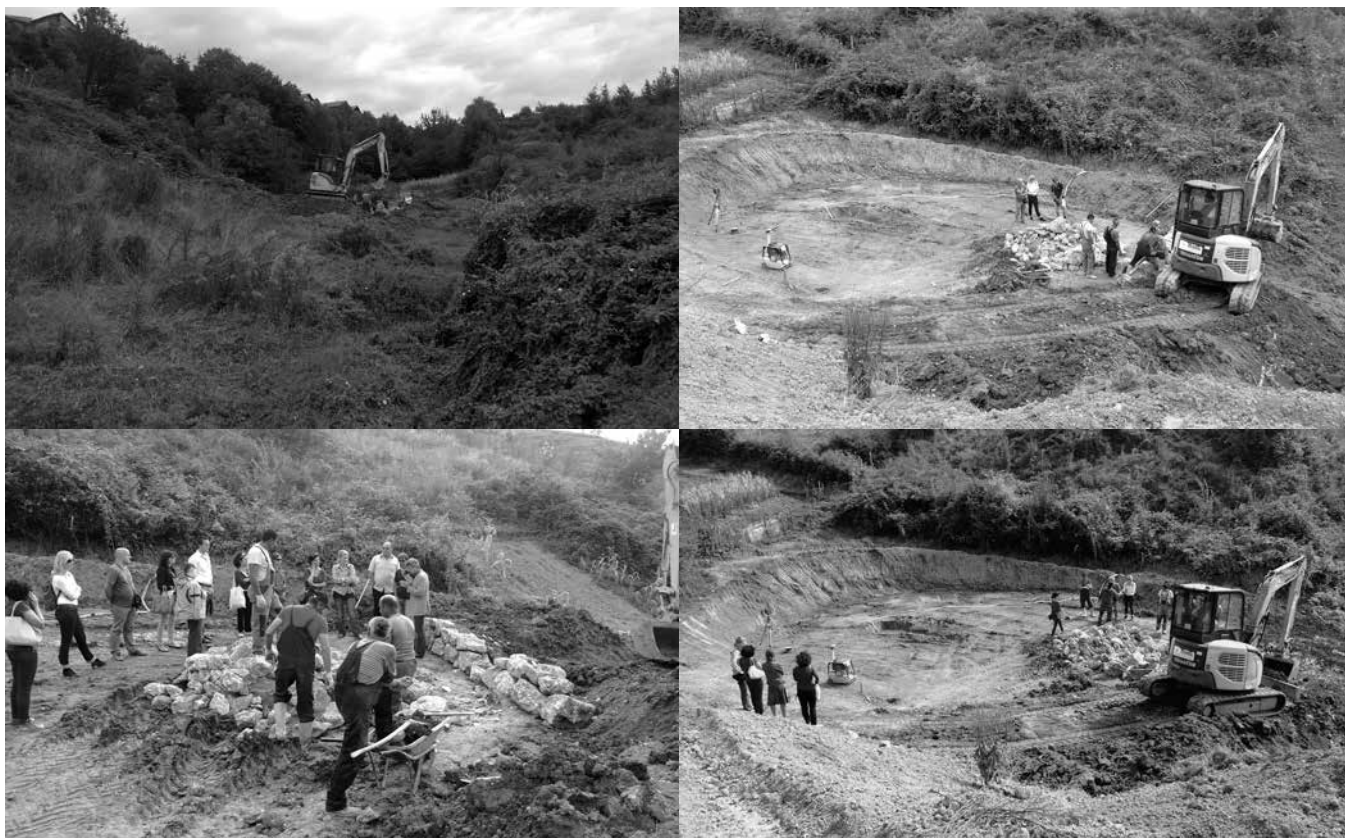
Fotografija 7. Izgradnja postrojenja za fitodepuraciju u sklopu Park šuma Mojmiło (Autor)
