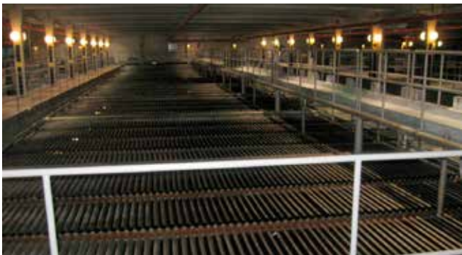
Slika 7: Lamelni taložnici RINGSJO postrojenja u Švedskoj (23.10.2011)
