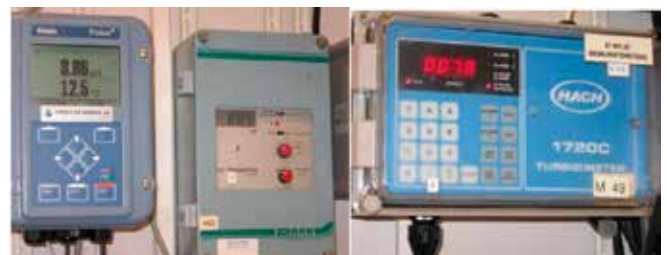
Slika 9: Rezultati mjerenja pH, temperature i mutnoće na izlazu iz postrojenja RINGSJO (23.10.2011)
