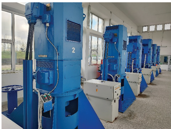
CS Tolisa, pumpni agregati, dovodni i odvodni kanali
