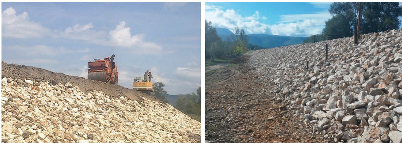
Rekonstrukcija nasipa uz rijeku Krupu (2014-2016)
