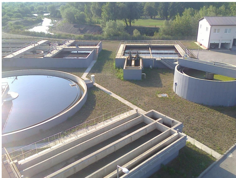
Slika 1. Izgled postrojenja za prečišćavanje otpadnih voda Živinica
