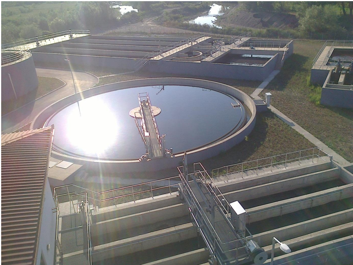
Slika 2. Izgled postrojenja za prečišćavanje otpadnih voda Živinica
