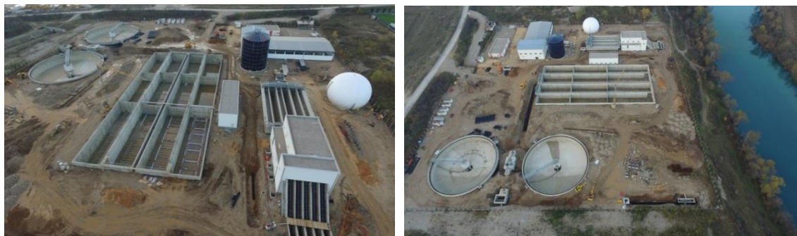
Slika: Izgradnja postrojenja za tretman otpadnih voda u Mostaru
