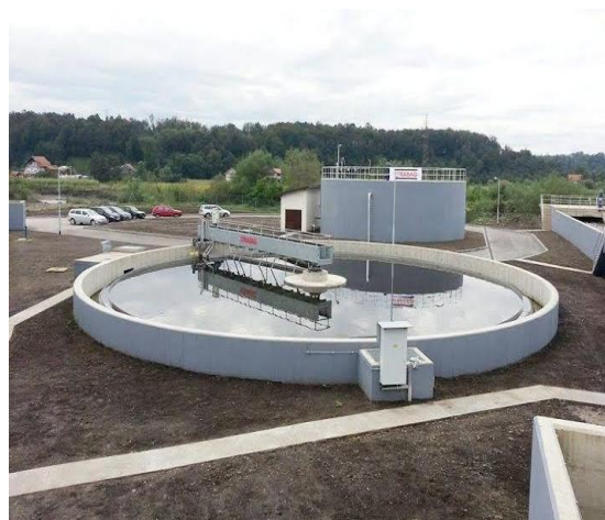
Slika 3. WWTP u Živinicama
