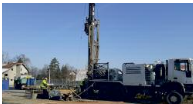
Slika 3. Radovi u toku izvođenja pijezometra ŽP-1 na lokaciji Strašanj - Živinice
