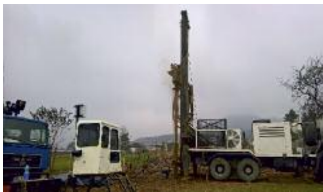
Slika 1. Radovi u toku izvođenja pijezometra MP-1 na lokaciji Misurici – Maglaj
