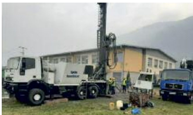
Slika 12. Radovi u toku izvođenja pijezometra VMP-17 na lokaciji Dobrinja - Visoko
